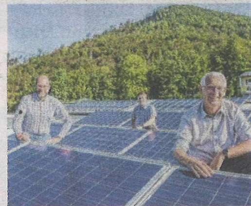
Die Photovoltaikanlage ist wieder voll einsatzfähig. Foto: Salzburg AG
